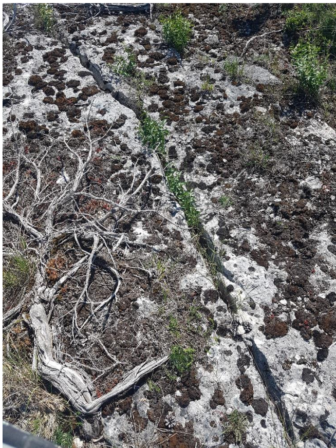
Figur 2: Tydliga ytsprickor i kalkstensberggrunden
