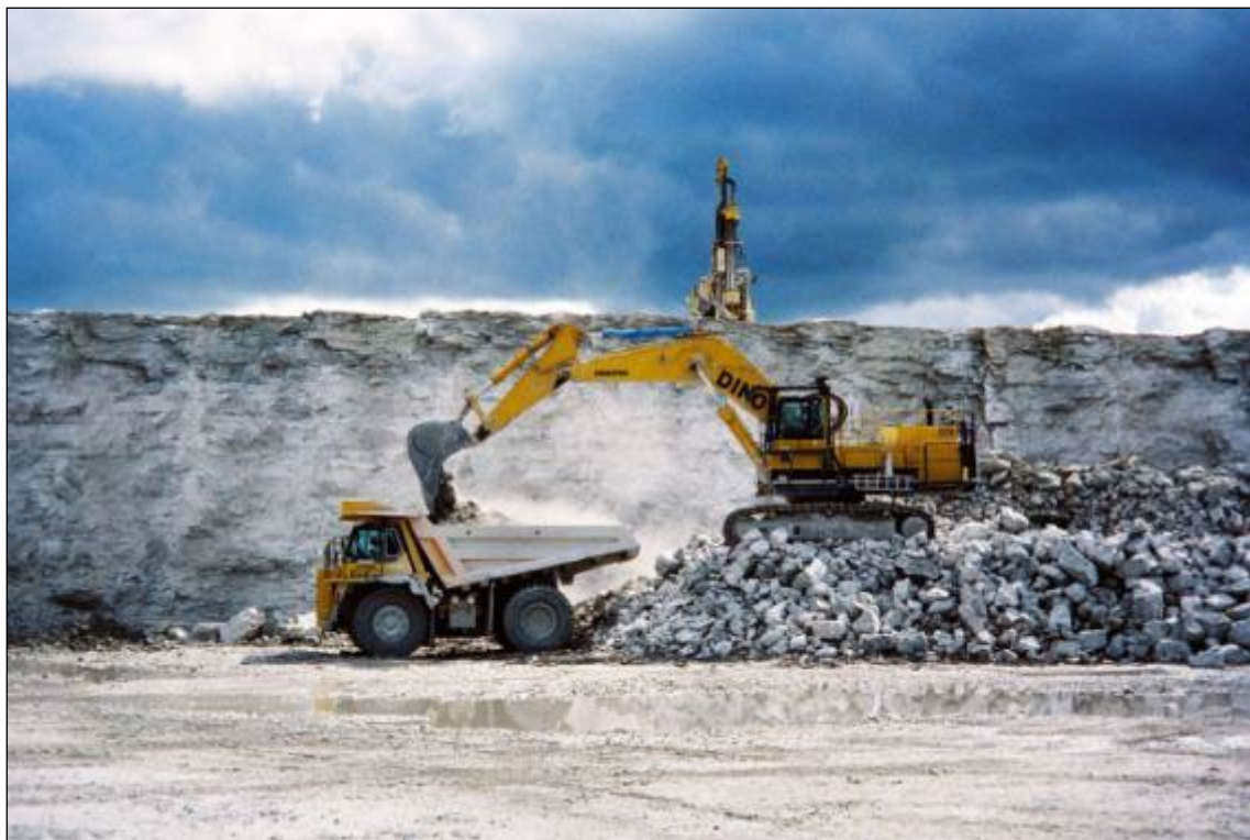
Figur 5. Bild över arbetsfordonen inom täkten. I bakgrunden syns en borrhigg på pallkanten. Nedanför lastar en grävmaskin upp sten i en truck för transport inom området till primärkrossen. Bilden är tagen i Klinthagentäkten (Foto Nordkalk).
